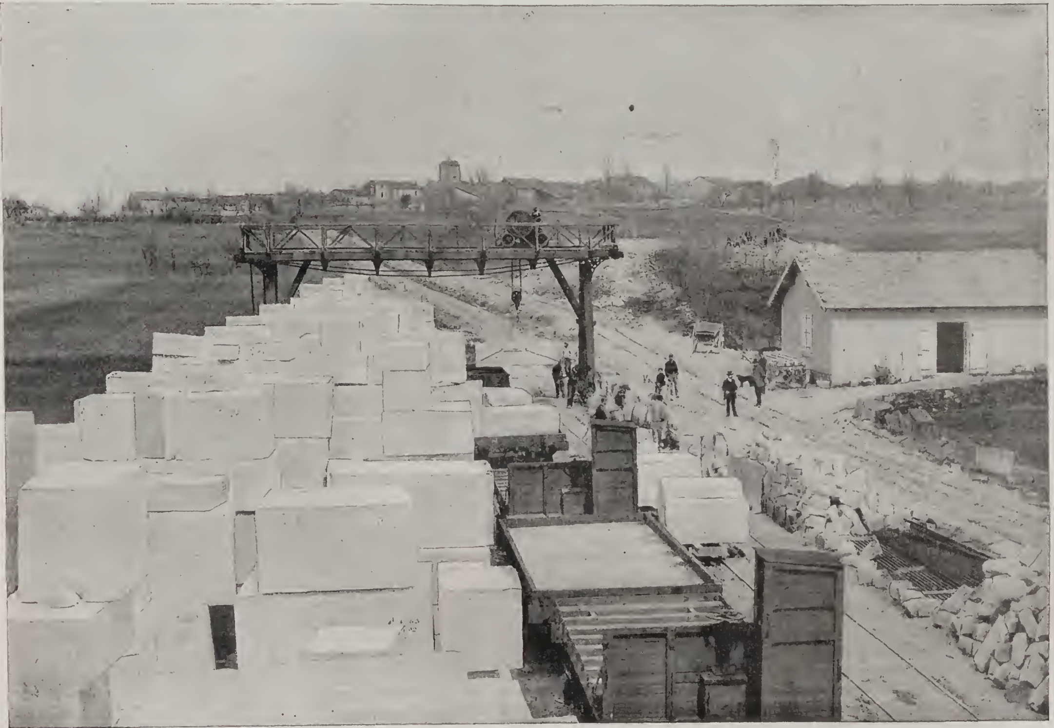
LES MATÉRIAUX DE L'EXPOSITION. — Sorties et raccords des voies ferrées de la carrière souterraine de Savonnières.
